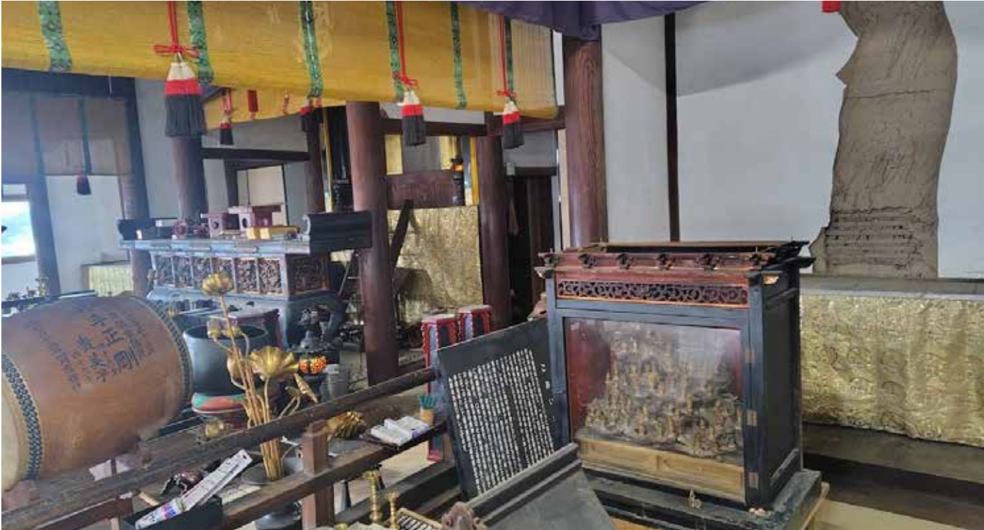
被害を受けた長壽寺本堂(九州西教区提供)
