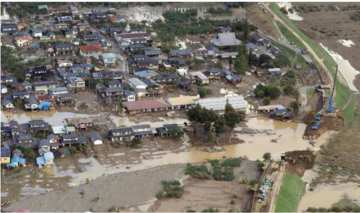
台風19号による豪雨で決壊した長野市を流れる千曲川 (写真提供 産経新聞社)
